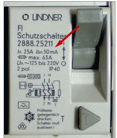
Bild 9: Auf der Frontseite des Fehlerstromschutzschalters sollte, wie in dieser Ausführung für den dauerhaften Einbau, der zum Auslösen führende Strom aufgeführt sein.
