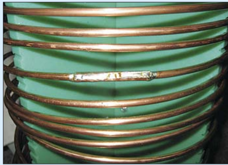
Bild 12: Verbindung zweier Kupferringe mittels darüber gestülptem, gerolltem Kupferblech und Fixierung durch Löten
