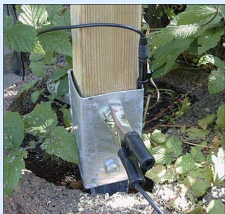
Bild 9: Zusätzliche Erdung an einer vorhandenen Einschlaghülse
